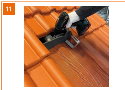
11. Dachhaken verschrauben und oberen Überstand der Universalpfanne 10 mm hochstellen. Hinweis: Sparrenschraube nicht im Lieferumfang enthalten
