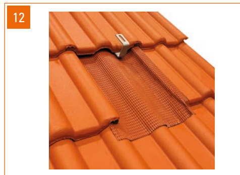
12. geba SD PV eindecken – fertig
