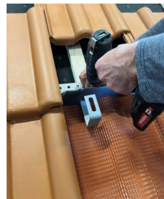
Dachhaken H36 montieren – fertig.
