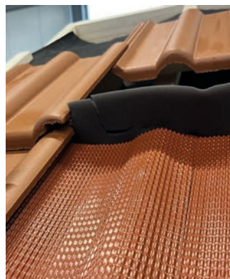
Dichtmaterial anbringen
